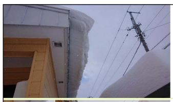
落雪の衝撃 (被害:外壁変形)
