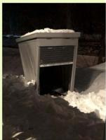
落雪の衝撃 (被害:外壁変形)
