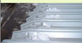
寒暖の繰り返しにより折板直上で氷結し、 屋根上雪が巻き垂れとなり跳ね出し荷重過 多となり損傷した事例。
