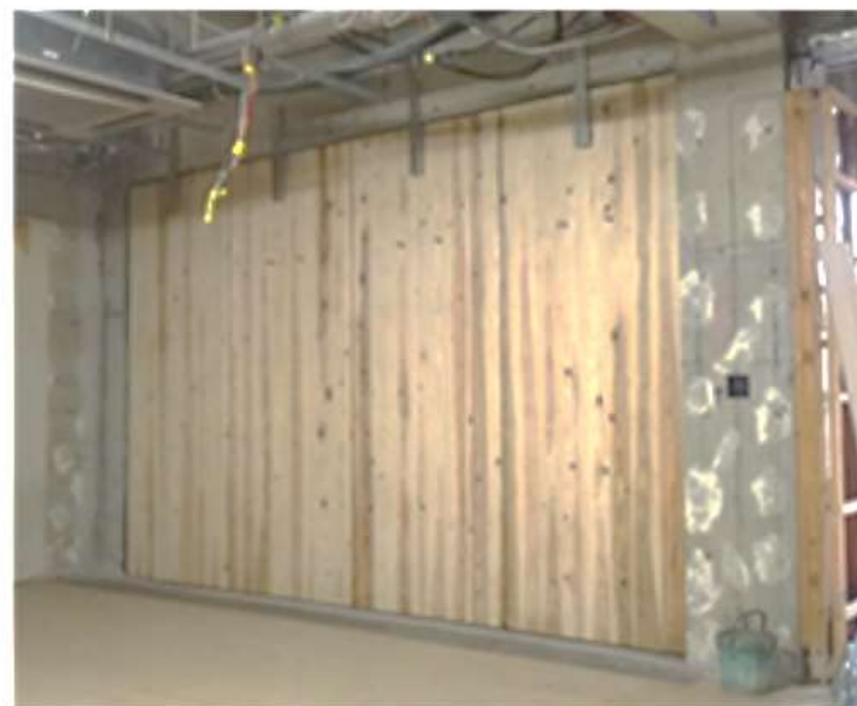
CLTを用いた耐震壁
