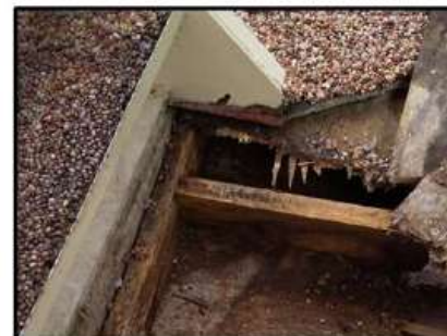
階段踏み板(1階)
