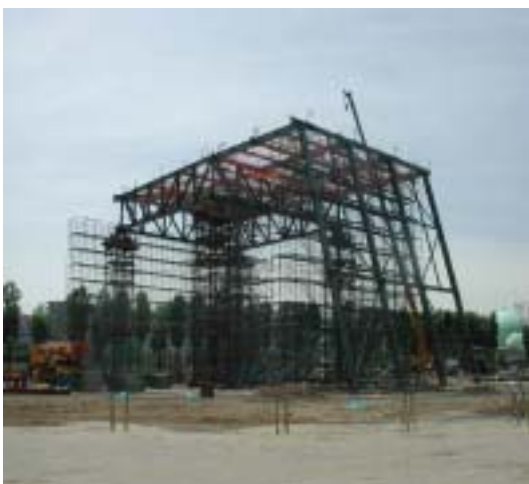
写真2 外周フレーム建て方
