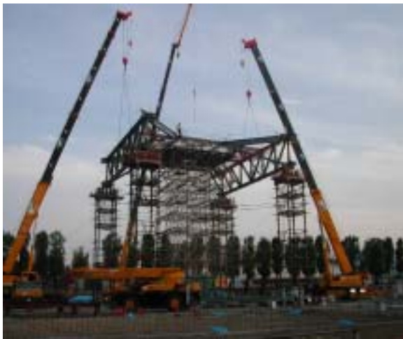
写真1 メイントラス建て方
