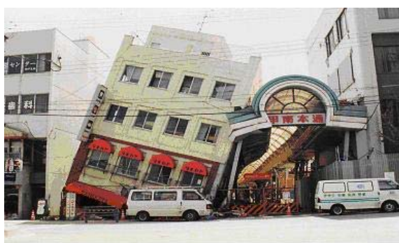
阪神大震災におけるRC造1F (ピロティ部)の崩壊
