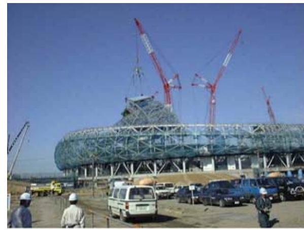
写真-1 屋根建て方状況
